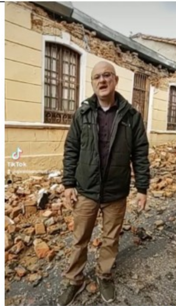
Imagen 19: Imagen tomada del video de Tik Tok realizado el día 28 de abril de 2022 por un ciudadano, donde se puede observar que las condiciones del muro estaban iguales a las observadas en la imagen No. 18.
