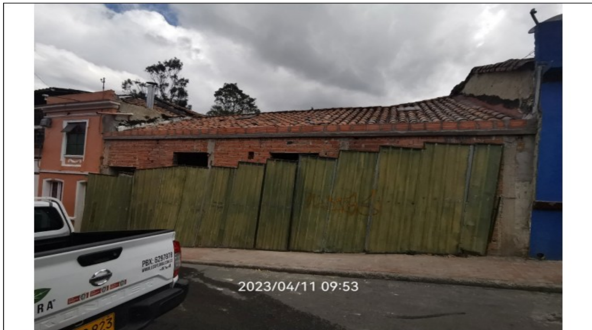
Fotografía 1: Fachada principal del inmueble sobre la Calle 9
